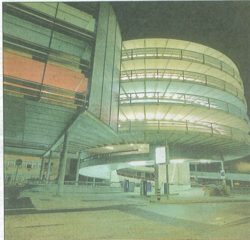
Route des Jeunes. La rampe hélicoïdale à double vis, côté Bachet-de Pesay, et, dans le prolongement, le parking proprement dit.
